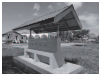
スラーチニエン小学校にて ①新設された手洗い場
